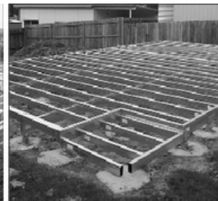
Estructura de hierro galvanizado
