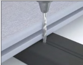
① Pretaladre un orificio piloto de profundidad sobre el producto.
